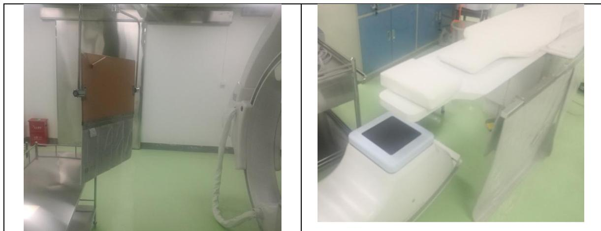
图10-2 DSA床体旁配置铅防护吊屏和床下铅帘参考图
