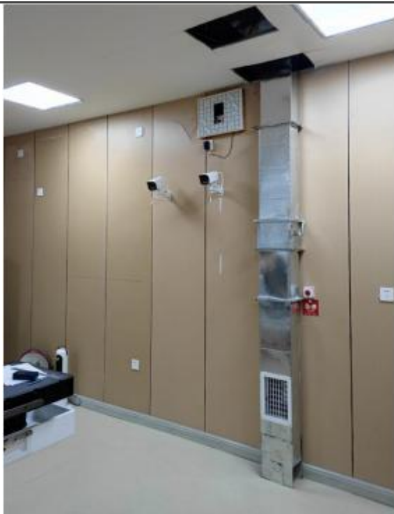
直线加速器机房内新增设置的排风管道
